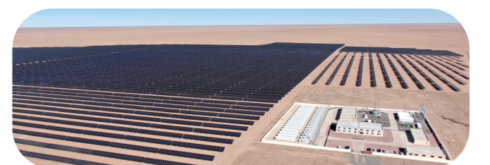
20万千瓦牧光储综合示范项目。
