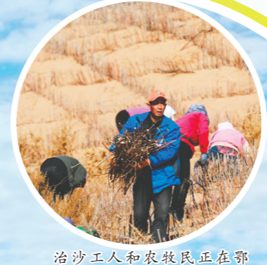
治沙工人和农牧民正在鄂托克前旗毛乌素沙地安装沙障。
