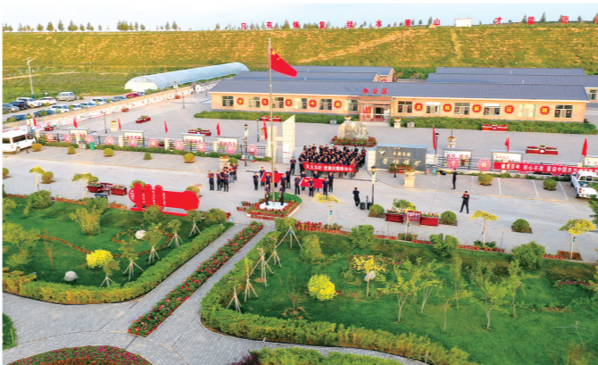
伊金霍洛旗乌兰集团荣恒煤矿花园式矿区。
