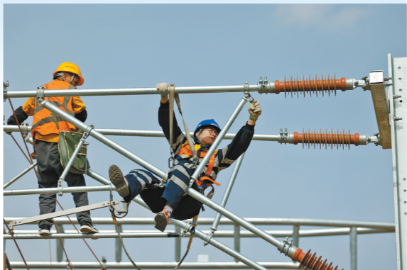
对接触网碗臂装置螺栓进行紧固。李宪 摄
