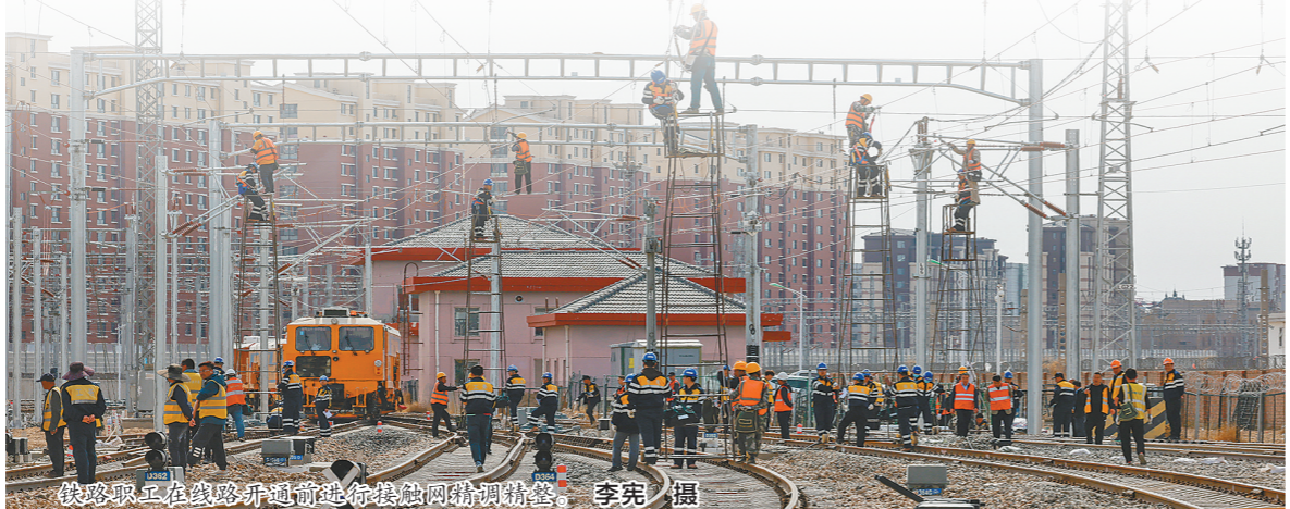
铁路职工在铁路开通前进行接触网精调精整。李宪 摄
