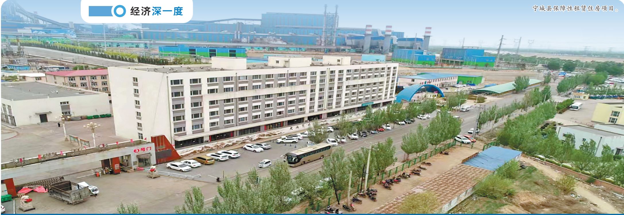
宁城县保障性租赁住房项目。
