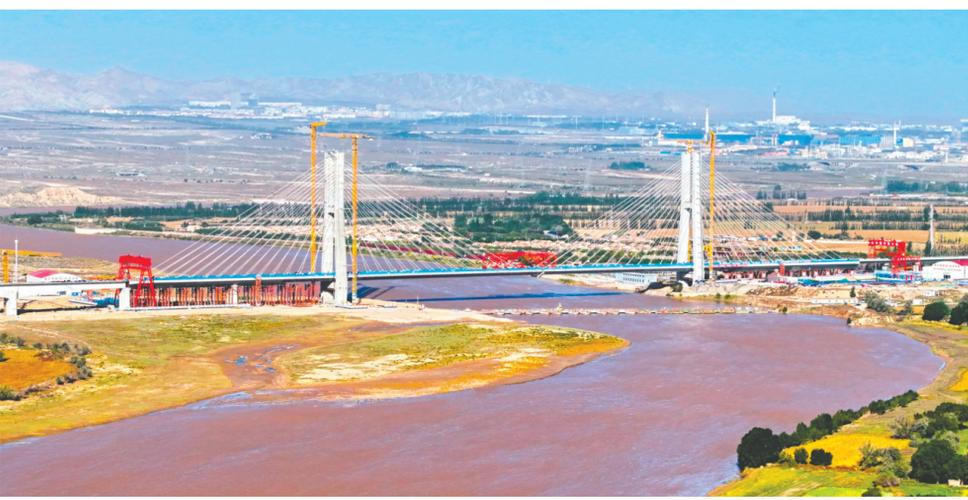
10月9日9时58分,随着最后一节钢箱梁应声落定精准对接,包银高铁乌海黄河特大桥顺利合龙贯通,标志着全线又一个重难点控制性工程取得新突破。
