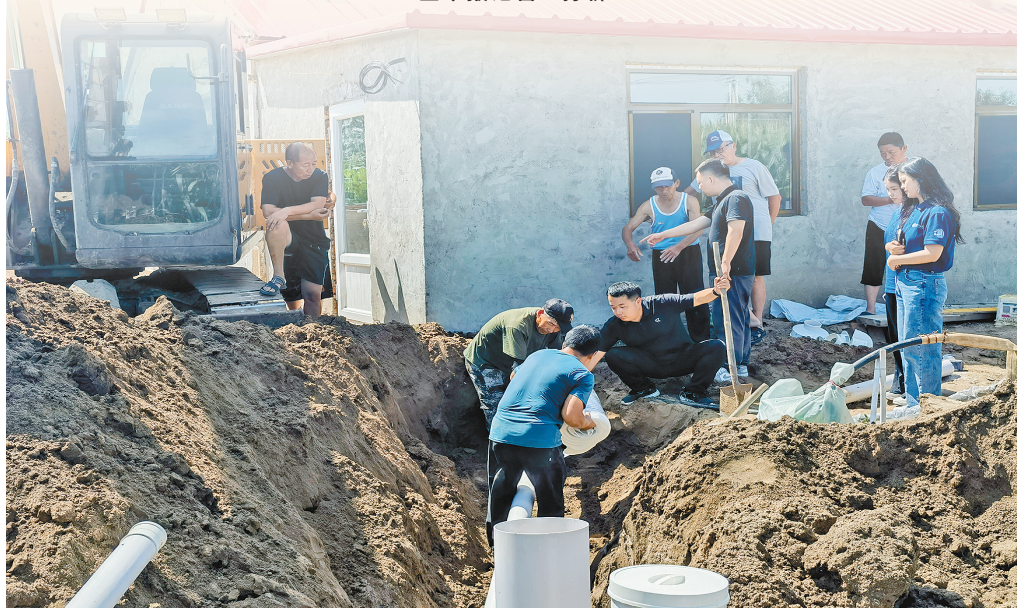
张宇与当地农牧民一起进行厕所改造施工。
