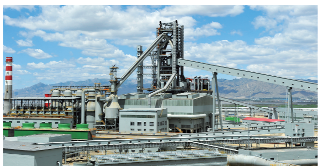
2014年,包钢第一座4000立方米7号高炉出铁,标志着包钢炼铁工艺技术、环保水平达世界一流水平。
