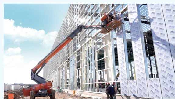
运达(阿拉善盟)新能源装备制造项目施工现场工人们正在厂房进行安装作业。
