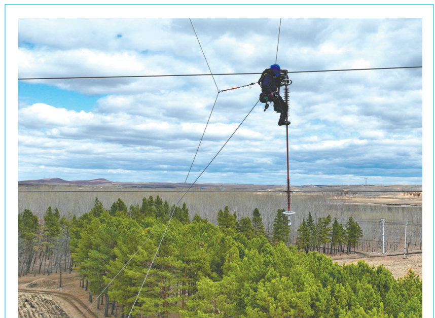
科技赋能高空作业
