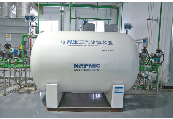
国家稀土功能材料创新中心固态储氢装置。 本报记者 王鹏 摄
