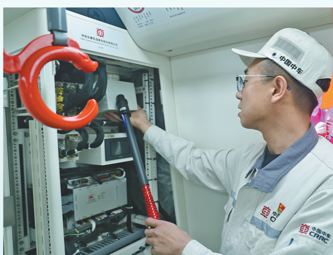
试验“烟火探测器辅助探测装置”。
