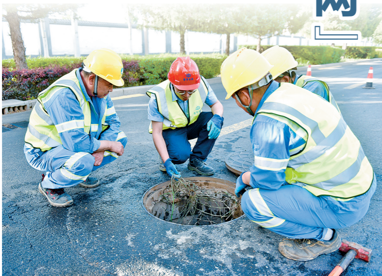
检查雨污水防坠网。
