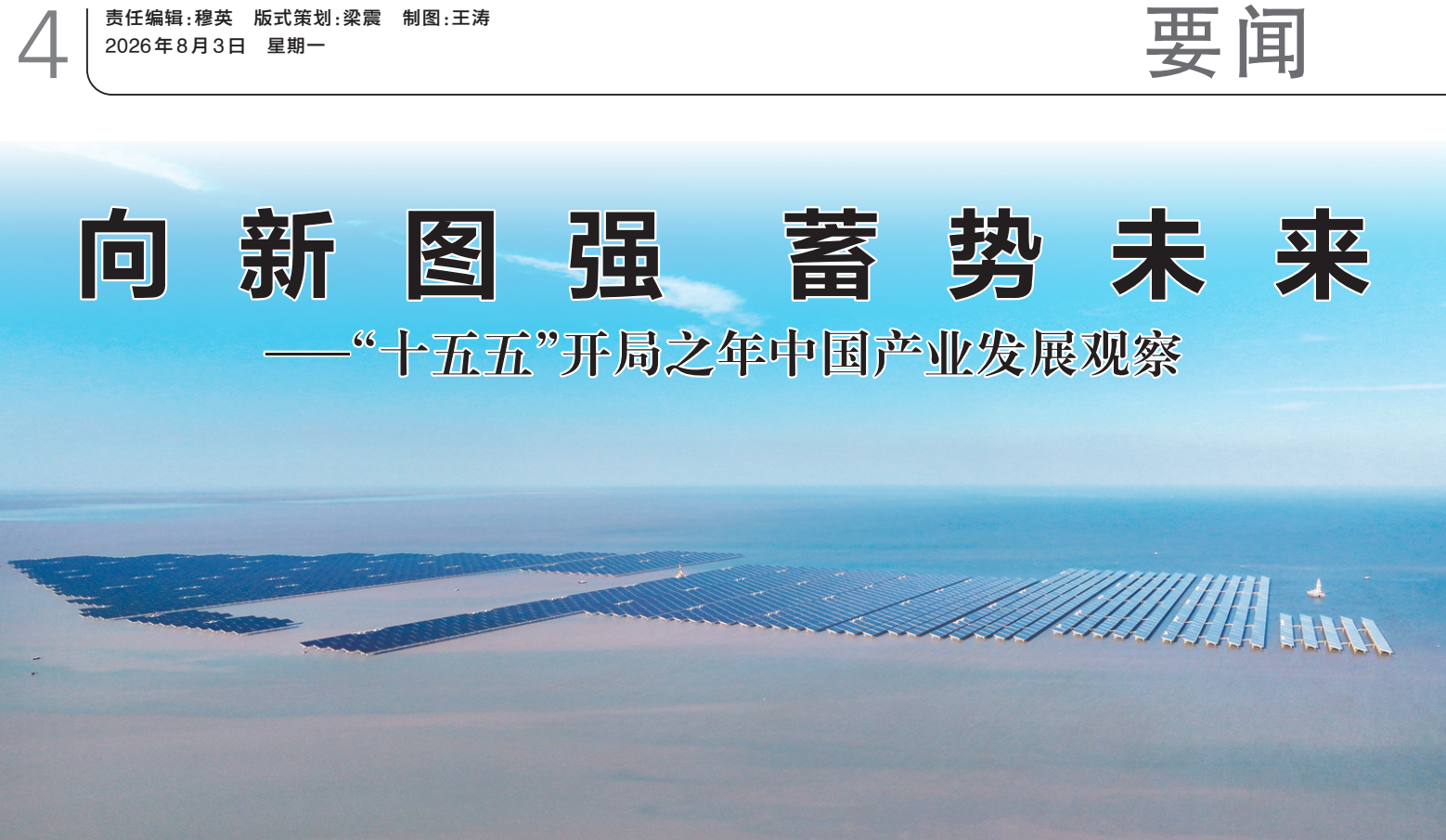
这是 2026 年 5 月 29 日拍摄的位于山东省东营市的吉瓦级桩基固定式海上光伏项目——国华 HG14 海上光伏项目（无人机照片）。
