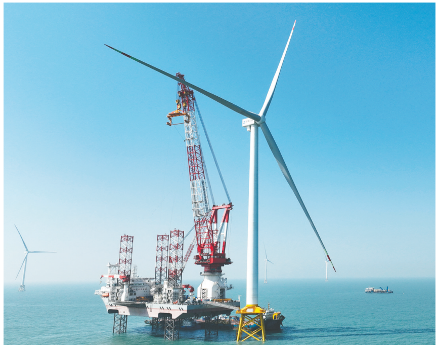
在三峡集团福建漳浦六整海上风电场拍摄的20兆瓦海上风电机组和“大桥风电”号2000吨自升式海上风电安装平台(2026年1月13日摄，无人机照片)。
