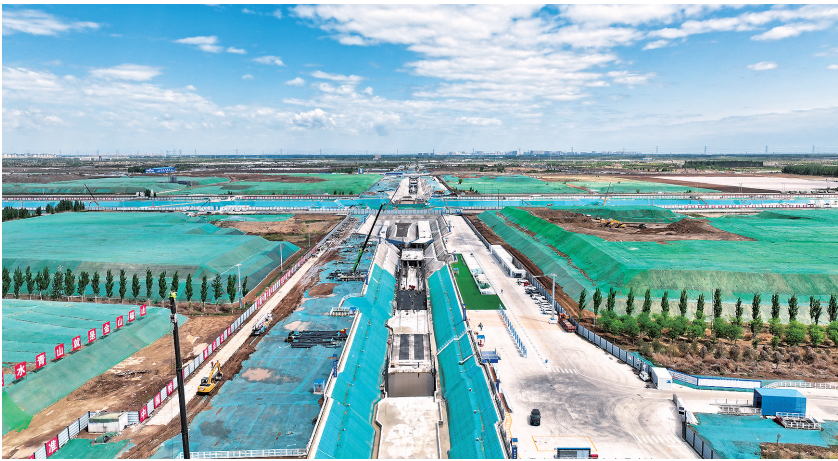
由中铁四局承建的雄安新区起步区NA12市政道路和综合管廊(二期)项目建设现场(2024年4月23日摄,无人机照片)。
