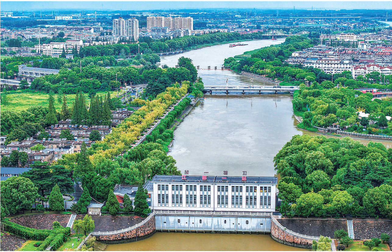
8月11日拍摄的位于江苏省扬州市江都区的南水北调东线源头江都水利枢纽一站(无人机照片)。
