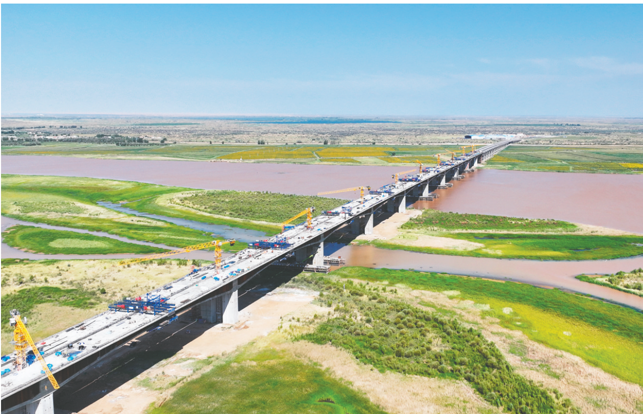
磴口黄河大桥左幅合龙
