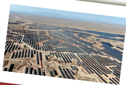
绵延铺展的光伏板为产业发展注入绿电支持。黄建飞 摄
