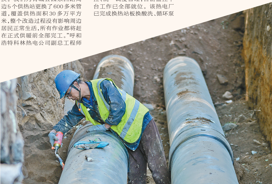
更换供热管道。
