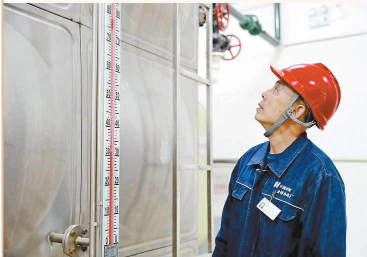
核对水箱水位,准备对二次管网注水。
