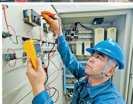
检修人员测量变频器绝缘,准备送电。
