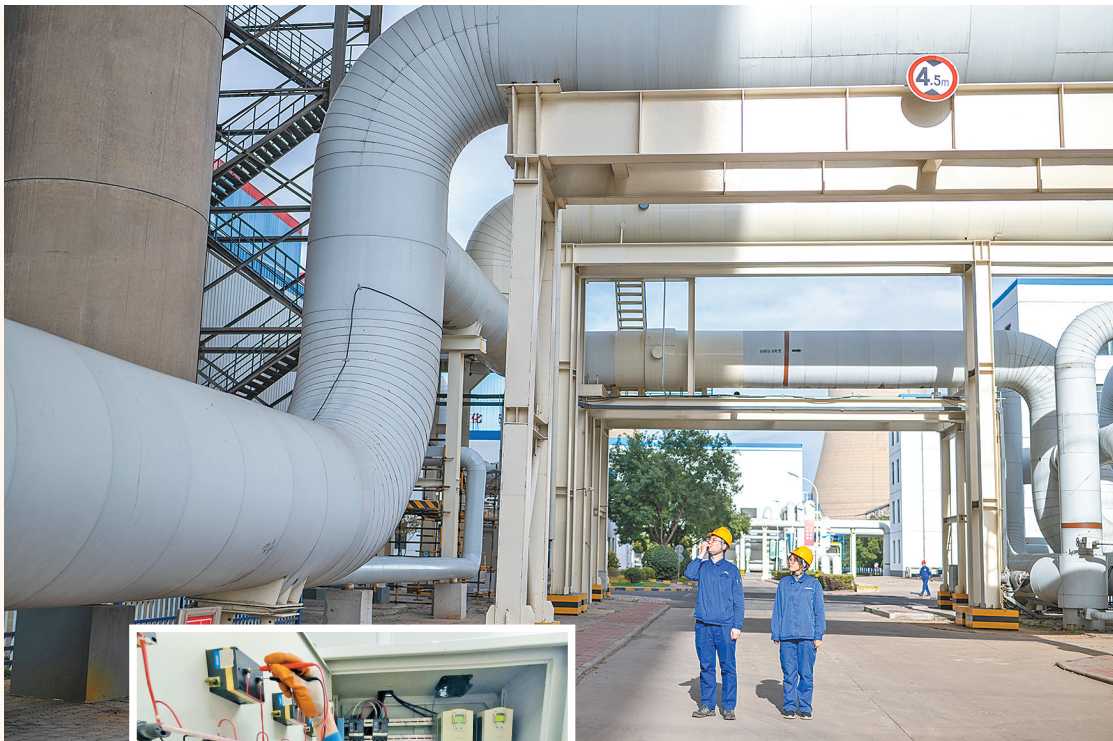
巡检热网管道。
