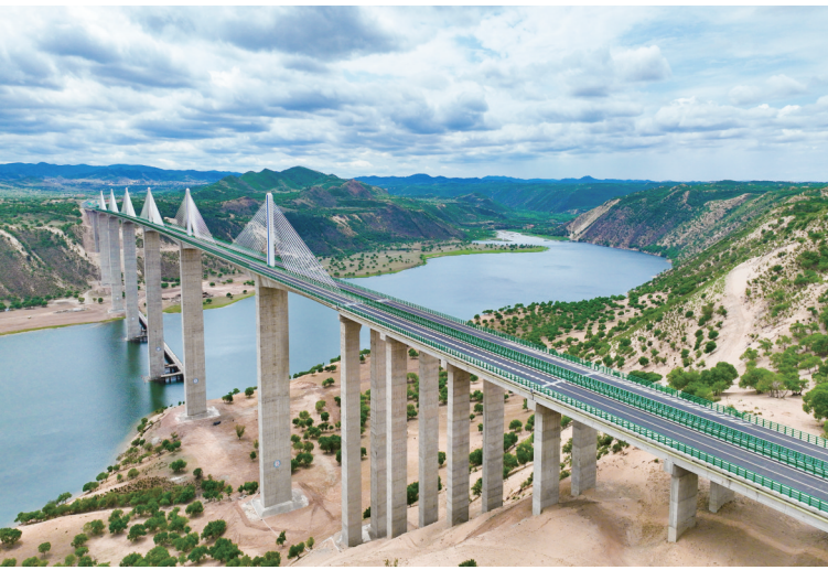
位于克什克腾旗境内的世界首座风积沙峡谷区多塔塔斜拉桥——西拉沐沦大桥建成通车。
