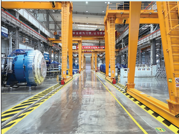
中车戚墅堰所风电传动有限公司车间。
